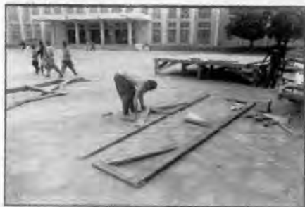
Construction de la scène
